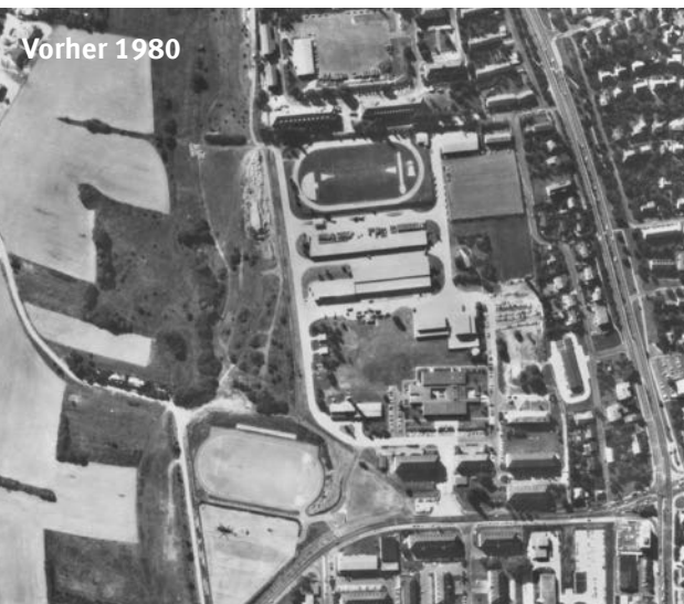
Ehemaliges Militärgelände in Kassel - vor und nach der Konversion (Quelle: Stadtverwaltung Kassel)
