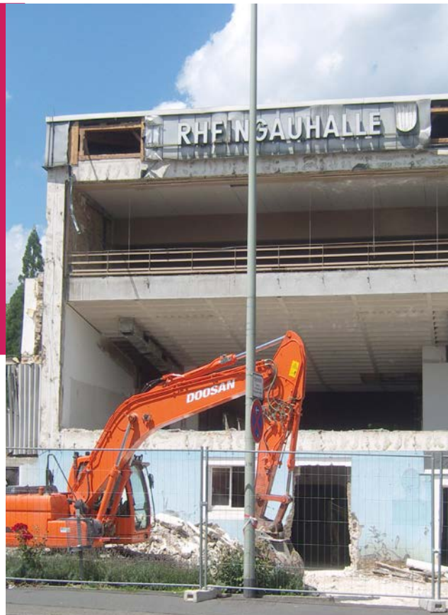
Abbruch der Rheingauhalle in Eltville im Rahmen eines Stadtumbauprojekts des Zweckverbandes (Quelle: Nassauische Heimstätte Wohnungs- und Entwicklungsgesellschaft)
